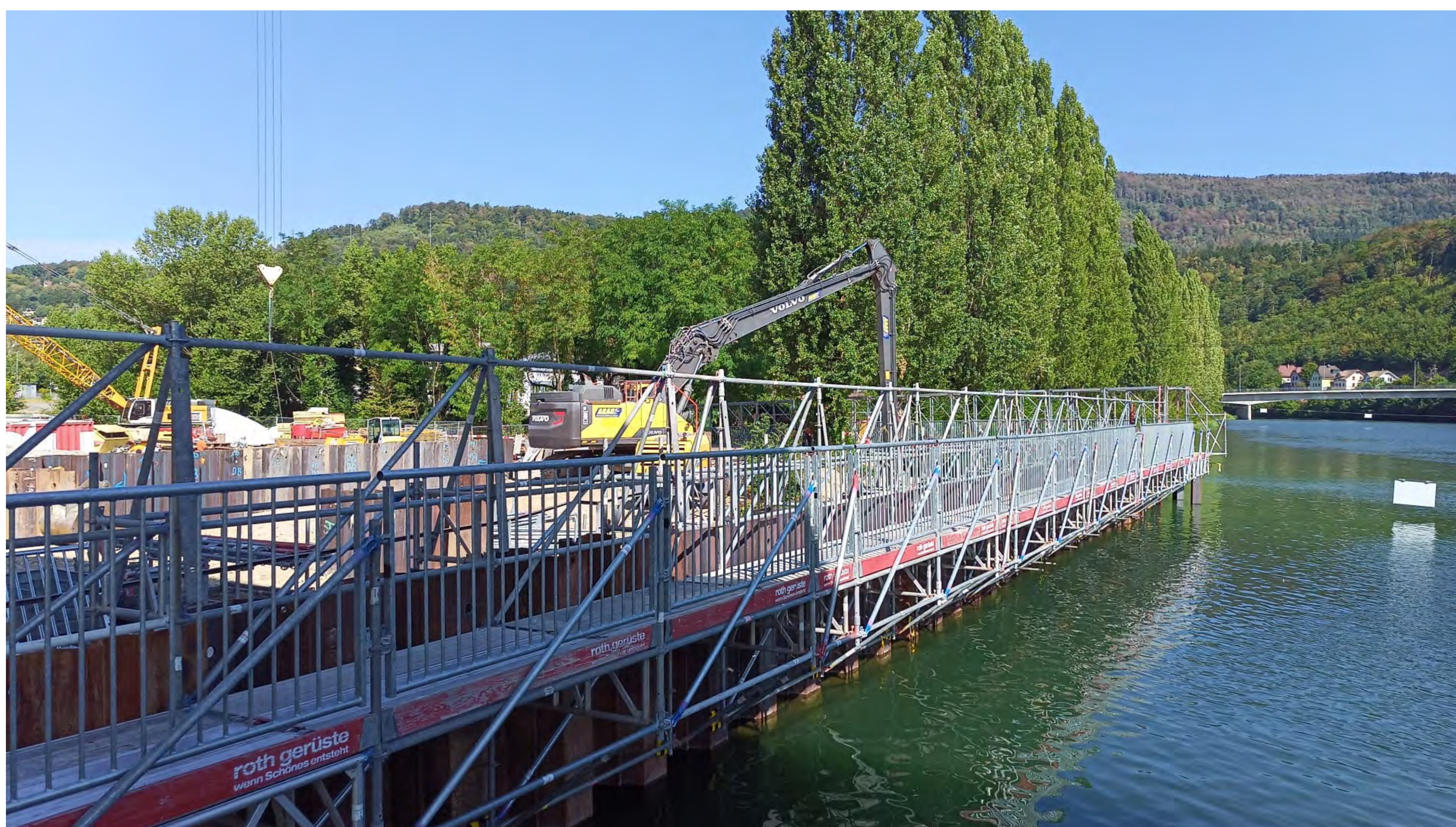
Um die Oltner Seite zu erreichen, wurde die bisherige Aarequerung mit einem provisorischen Steg ergänzt.
