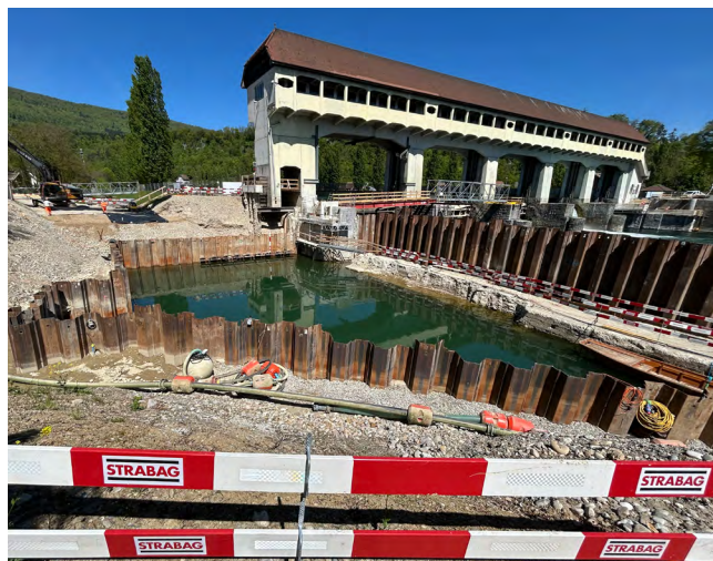
Blick auf die Baugrube – noch gefüllt mit Wasser. Hier entsteht der Bau für das neue Restwasserkraftwerk.
