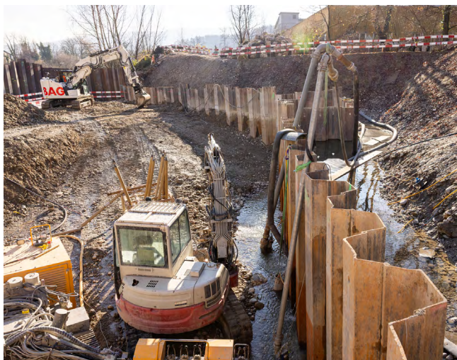
Eingerammte Spundwände vor dem Aushub der Baugrube des Restwasserkraftwerks.
