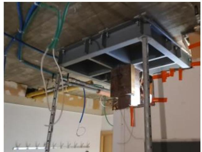
Einpackung Stahlkragen: Verkleidung mit speziellen Brandschutzplatten (Schritt 3)
