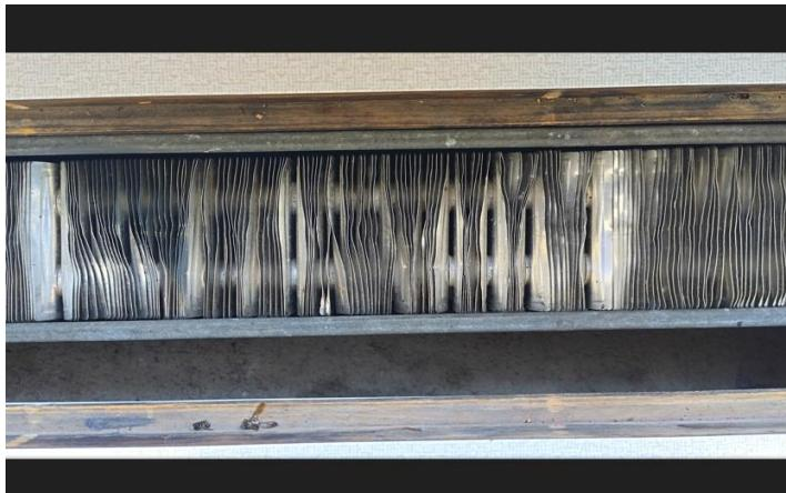
Probleme macht zunehmend die Funktion der Konvektoren. Eine gute Wärmeabgabe über die Luft, welche die Lamellen durchströmt, ist nicht mehr überall erfüllt. Die Lamellen sind grossenteils verbogen oder zusammengedrückt.
