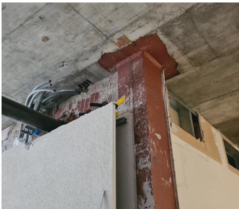
Weitere Freilegung Stahlstütze: Platz für Konstruktion Stahlkragen (Schritt 2)
