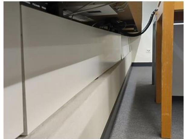
Nach wie vor gibt es fertige Brüstungssysteme, welche verbaut werden können, und die für die Verschalung durch den Schreiner vorbereitet sind. Die Baukommission hat sich damit befasst und die Lösung als geeignet befunden. Im neuen Brüstungssystem ist ein integrierter Kabelkanal verbaut, welcher flexible Standorte für Steckdosen jeglicher Übertragungen zulässt.
