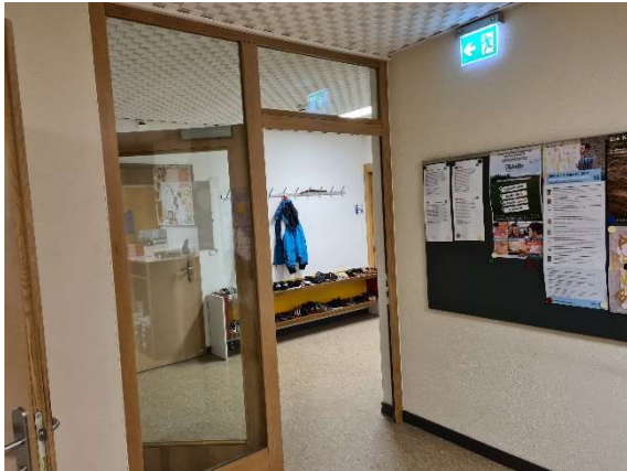
Abb. 19, Vorraum Office best. Trennwand
